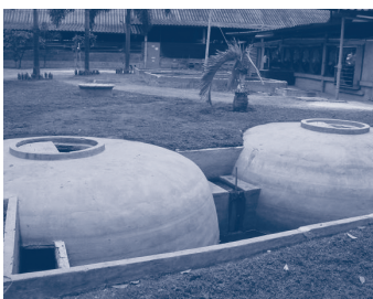
รูปที่ 9 ตัวอย่างปอ่โดมคงที่ (Fixed Dome)
