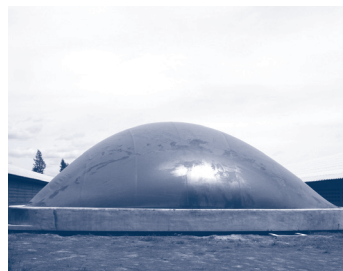
รูปที่ 6 ตัวอย่างระบบบ่อคลุมไร้อากาศ (Covered Lagoon)
