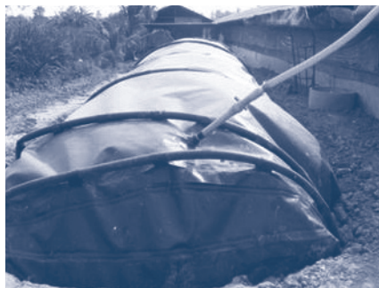
รูปที่ 8 ตัวอย่างปอ่ก๊าซชีวภาพสำเร็จรูปขนาดเล็ก (Package Biogas)
